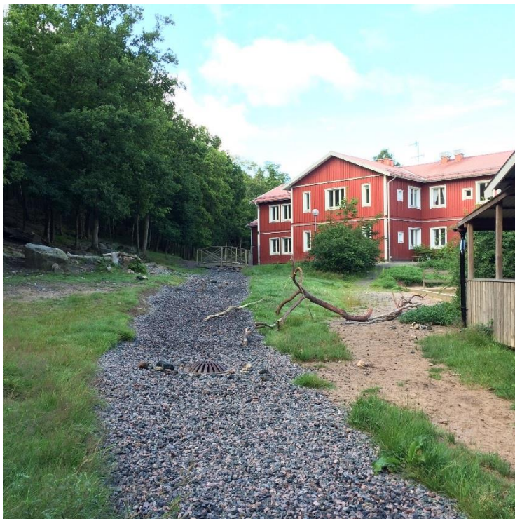
Figur 10. Exempel på makadamdike i Göteborg. Liknande typ kan anläggas på kvartersmark inom detaljplanen för rening och fördröjning.
